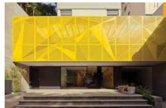
İkincil cephe sistemleri; mevcut mimari yapıdaki var olan cam ve ya betonarme yapılar da öne çıkarma suretiyle yapılan görsel ve teknik fayda sağlayan sistemlerdir. Amaç modern mimari görünüş yanı sıra olumsuz hava şartlarına karşı önlem amacıyla kullanılmaktadır. Alüminyum levha ve profiller ilk sırada olmak üzere pek çok malzemeden üretilmiş olan panellerle bina cephelerine dekoratif bir görünüm kazandırmaktadır.
