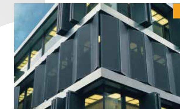
Güneş kırıcılar, yapı tasarımlarında enerji kontrolünü sağlayabilmek, güneş ısı ve ışığını kontrollü şekilde kullanabilmek amacıyla tasarlanarak üretilmiştir. Güneş kırıcı profilleri alüminyum, cam veya perfore alüminyum materyallerinden, değişik ölçülerde ve formlardadır. Sabit ve hareketli tasarıma sahip güneş kırıcıları ve türleri sıklıkla talep edilmektedir. Projelerde isteklerinize uygun formlarda özel güneş kırıcı imalatları da yapılmaktadır.
