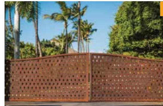
Retro görünüm elde edebilmek amacıyla Corten çelik tercih edilmektedir. Sadece dış mekanda ve cephelerde değil; iç mekanda da kullanılan bir malzemedir. Yüzeydeki pas tabakası korozyonun metalin derinlerine inmesini engellediğinden uzun ömürlüdür.
