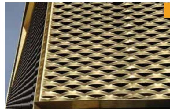
Genişletilmiş metal mesh panel ürünler, özel boşluklu dokusu ile kusursuz ışık ve hava geçirgenliği sağlamaktadır. Açık yüzeyi ve transparan görünümü ile ışıklandırma ve hava sirkülasyonu bakımından pek çok avantaj sağlayan genişletilmiş metal mesh paneller, son derece dayanıklıdır.
