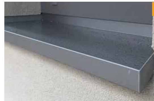
Mermiş şekillendirilememesi ve mermer maliyetinin yüksek olması sebebi ile günümüz şartlarında alüminyum denizlikler modern yapılarda tercih edilmektedir. Alüminyum kullanılarak üretilmiş olan denizlik profilleri, elektrostatik toz boyası ile istenilen renkte üretilerek kullanılmaktadır. Kullanılan elektrostatik toz boyası dış etkilere karşı alüminyum materyalini en iyi şekilde muhafaza etmektedir.
