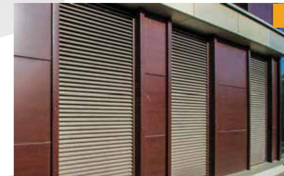
Metal menfezin genel olarak kullanım alanı; hava geçirgenliğini sağlamak, ısı, yağış ve ışığı kesmek amacıyla kullanılmaktadır. Çatı üzerindeki havalandırma sistemlerinde; atık hava üniteleri bulunan tüm alanların hava sirkülasyonu sağlamak için alüminyum ya da galvaniz çelikten üretilmektedir.
